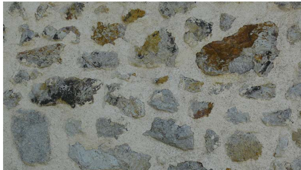
Mûr en moellons de champ jointoyée au mortier de chaux
