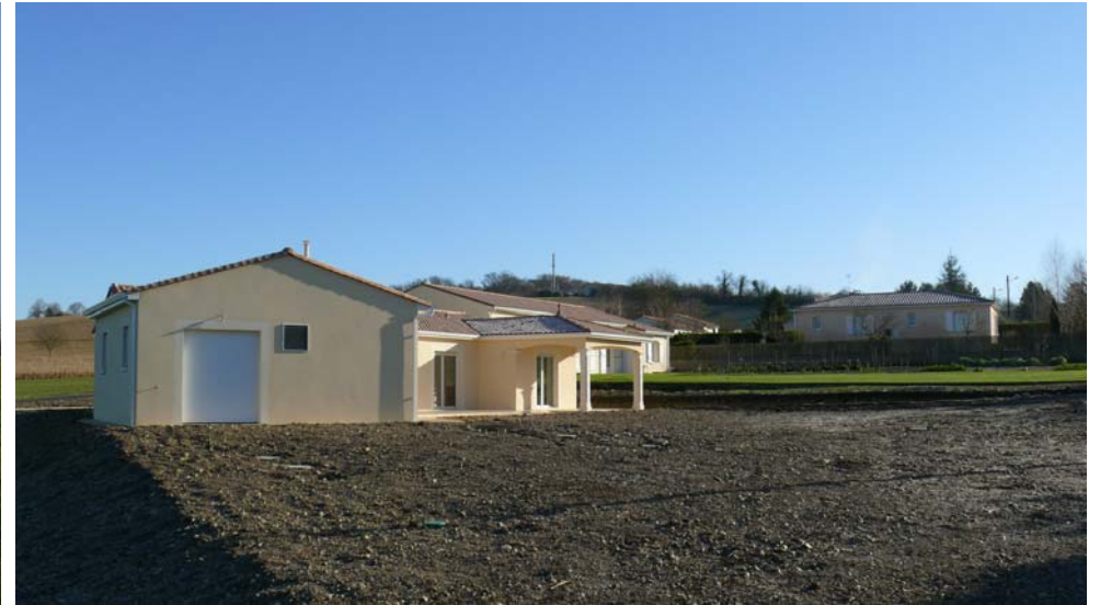
Saint-Amand de Montmoreau : l'absence de dispositifs d'insertion paysagère à l'abord des voies de circulation
