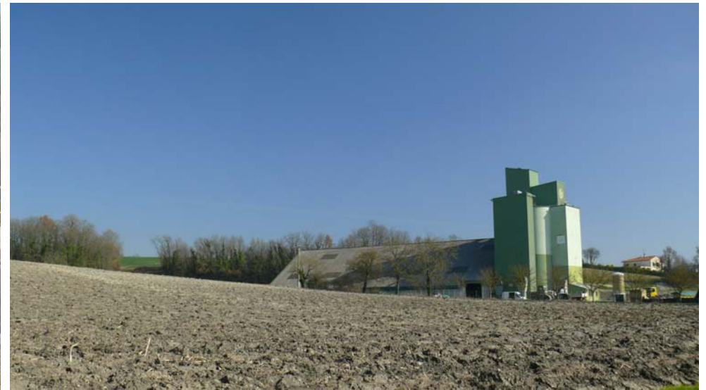
Les silos à Salles-Lavalette qui expriment tout le poids de l'activité agricole dans le maintien des qualités paysagères du Pays
