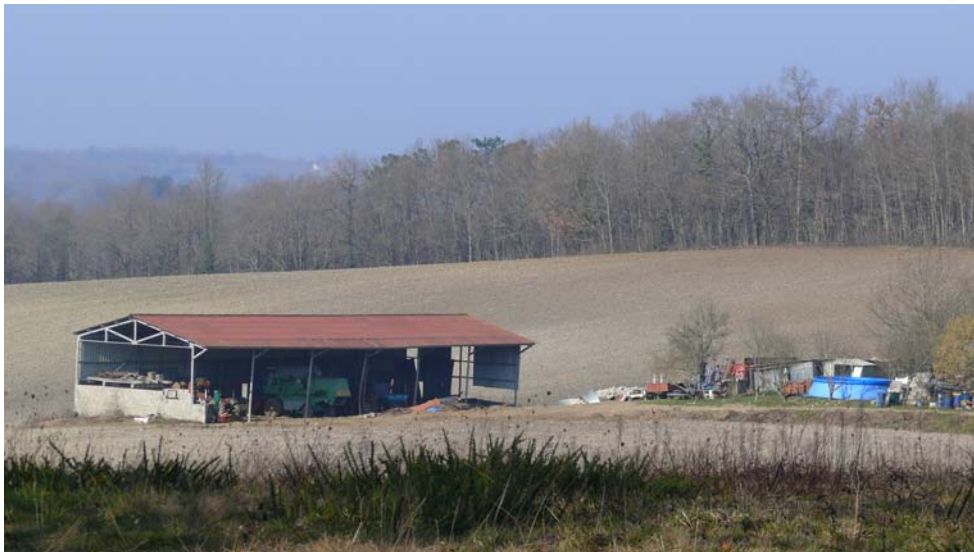
Une surexposition du bâtiment à l'échelle du grand paysage
