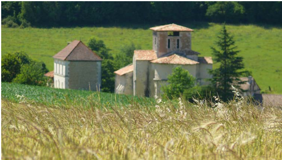
Eglise de Saint-Quentin de Chalais
