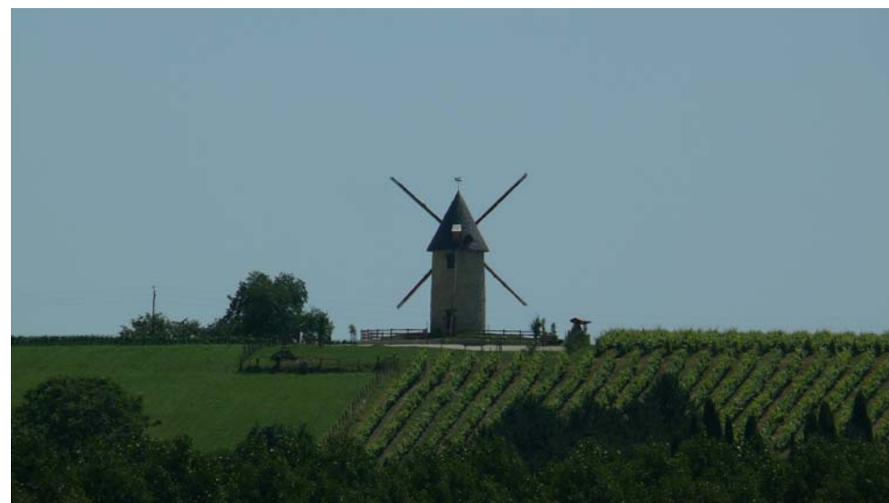
Le moulin restauré à Condéon
