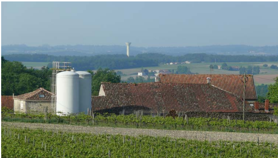
Exploitation viticole à Jurignac dont le profil est dominé par les cuves de stockage
