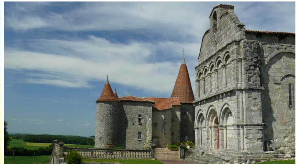
Château et église de Chillac
