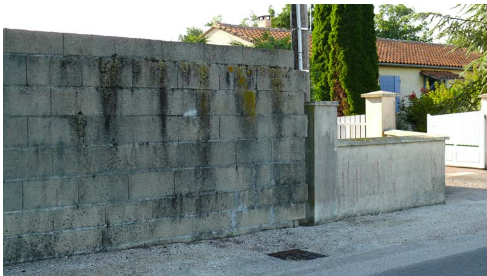
Disparité des matériaux et des revêtements
