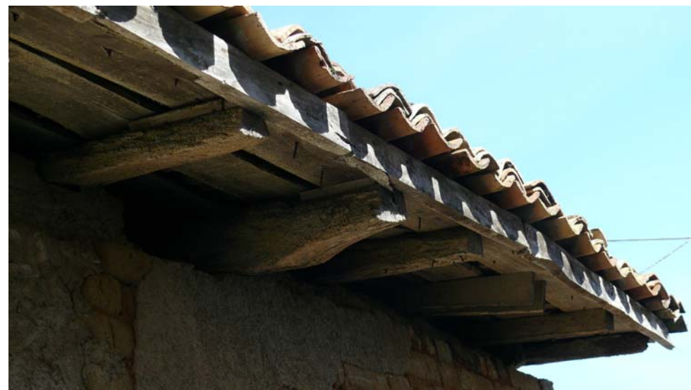
Avancée de toit
