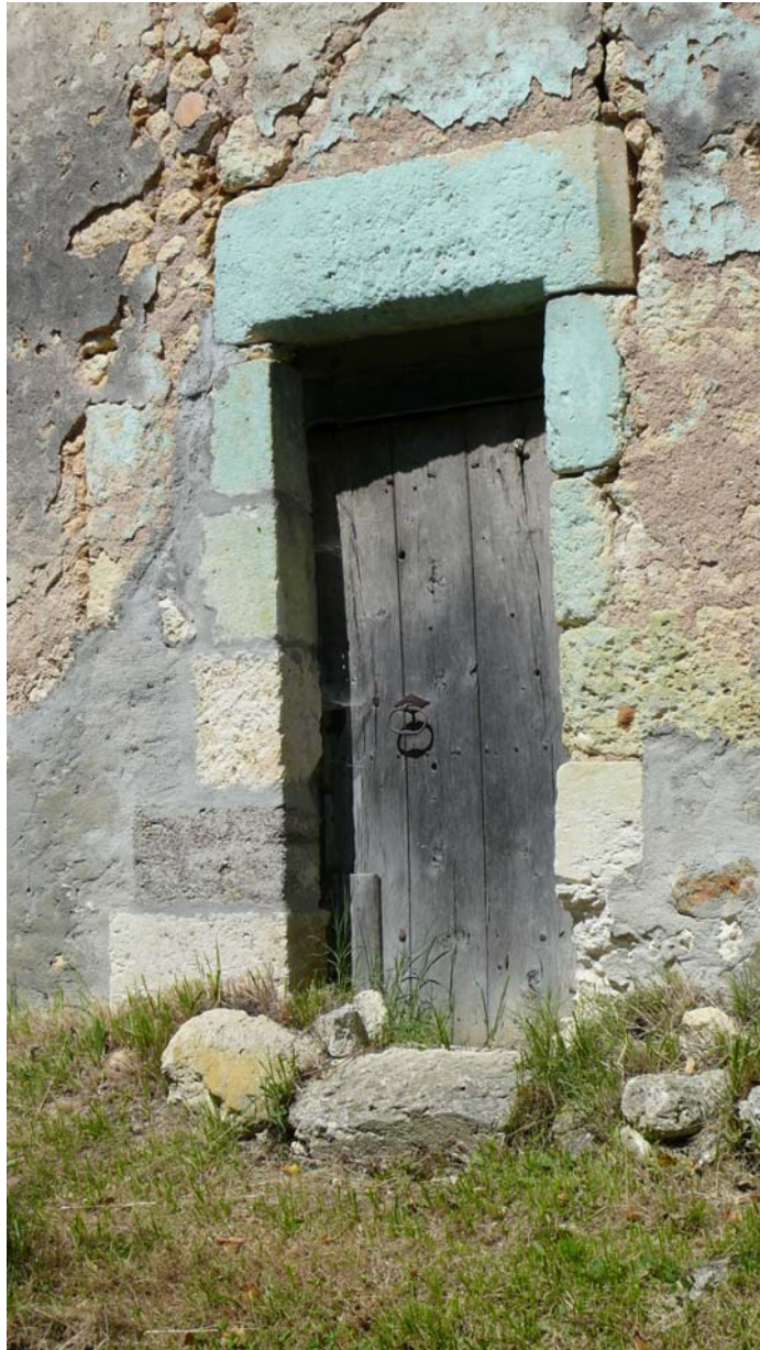
Porte à montants en pierre de taille tâchée par la bouillie bordelaise
