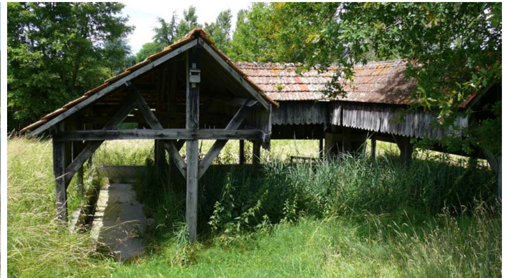
Lavoir à proximité de l'étang Vallier à Brossac
