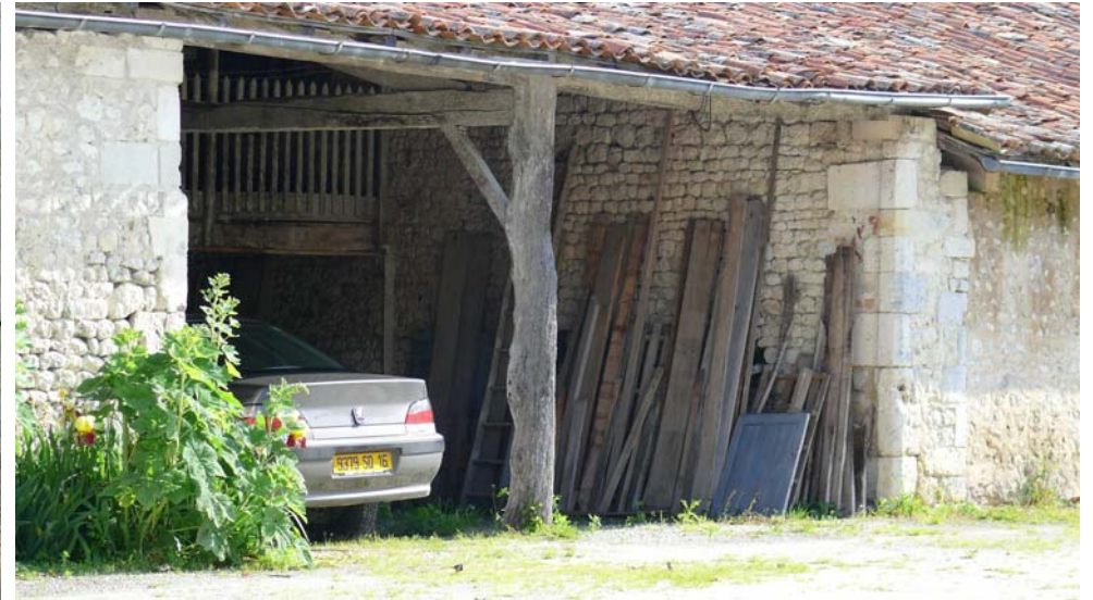
Appentis liant deux bâtiments d'une ferme
